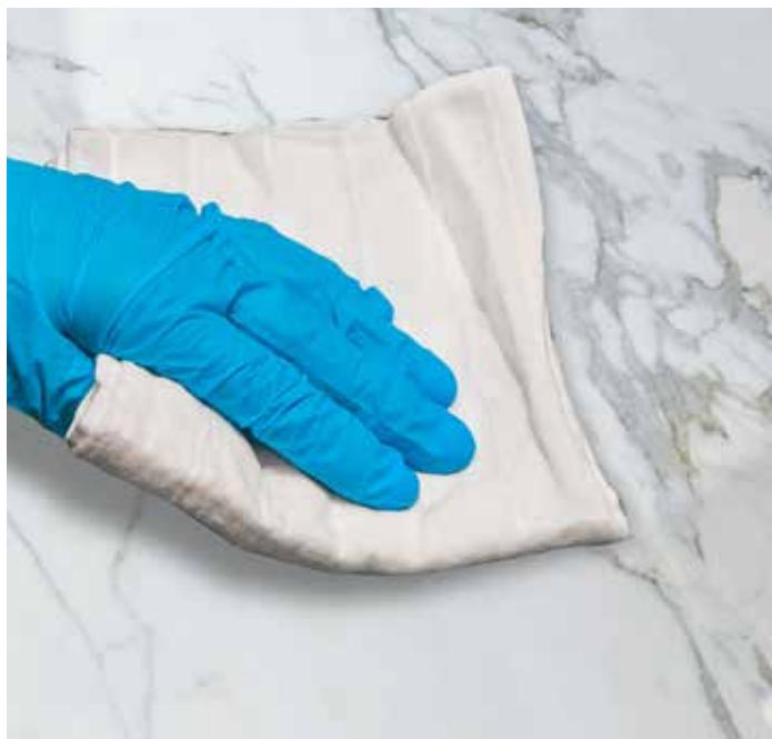
L'applicazione del trattamento di protezione antimacchia delle superfici è un importante fase di lavoro che salvaguarda nel tempo il materiale da attacchi di inquinanti atmosferici, di natura organica ed inorganica, mantenendo la traspirabilità e la naturale colorazione della superficie senza creare antiestetici film chimici.
